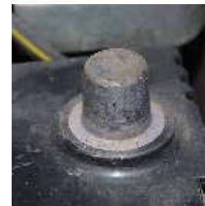
バッテリー端子腐食確認
